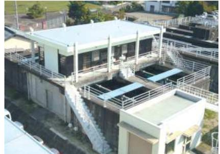
沈殿池で沈まなかったゴミを砂の層で取りのぞきます。
