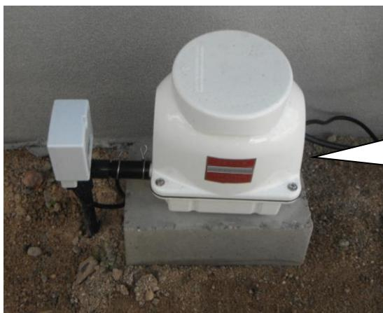
プロワは浄化槽の中の微生物に空気を送る機械です。
