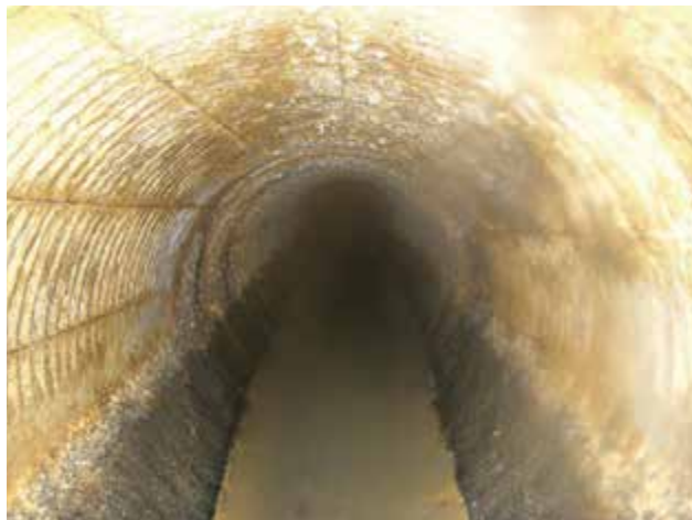
下水道管路の様子（更生前）
