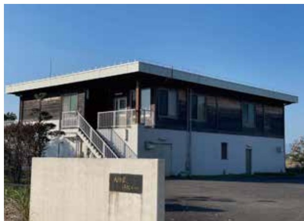
蓮池地区農業集落排水処理施設
