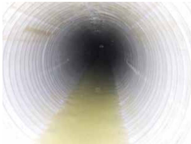
下水道管路の様子（更生後）
