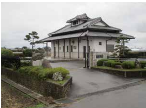
諸富北部地区農業集落排水処理施設
