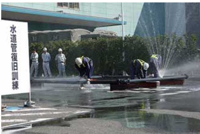
水道管復旧訓練の様子
