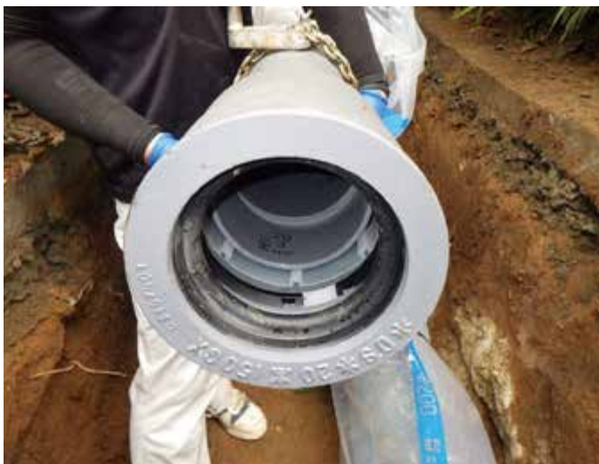
耐震管（GX形水道管）
