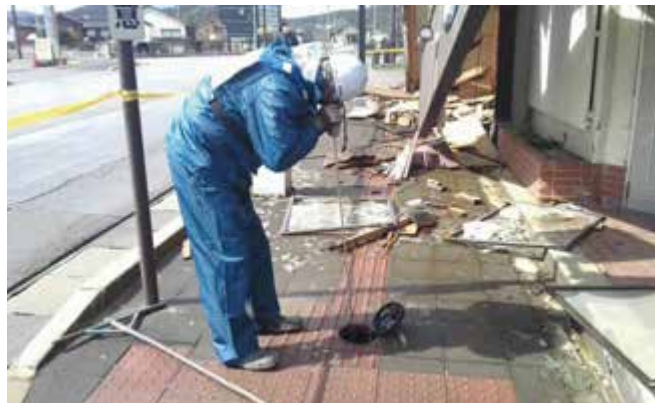
漏水調査の様子（石川県輪島市）
