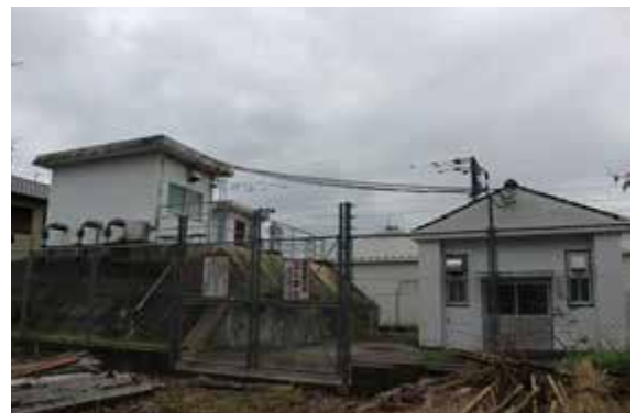
春日第1浄水場
