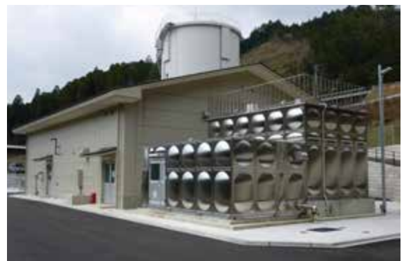
富士中央浄水場
