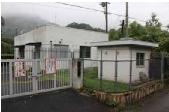
春日第2浄水場
