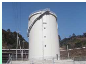
富士中央水道施設配水池
