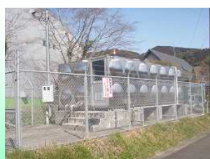
富士南部水道施設第二配水池
