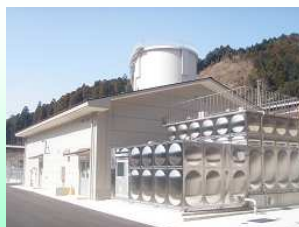
富士中央水道施設棟
