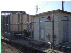
富士南部水道施設第一配水池
