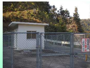
大和柚木水道施設配水池
