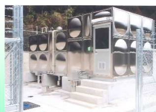
富士中央水道施設配水池(貝野地区)
