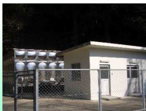
松梅北部水道施設配水池
