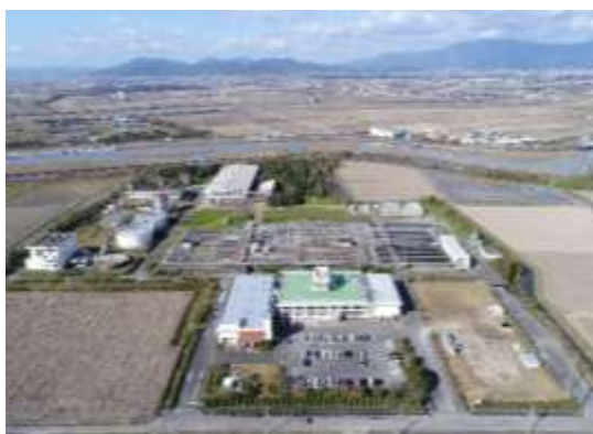
下水浄化センター
