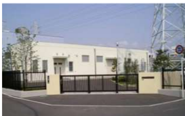
下高木ポンプ場
