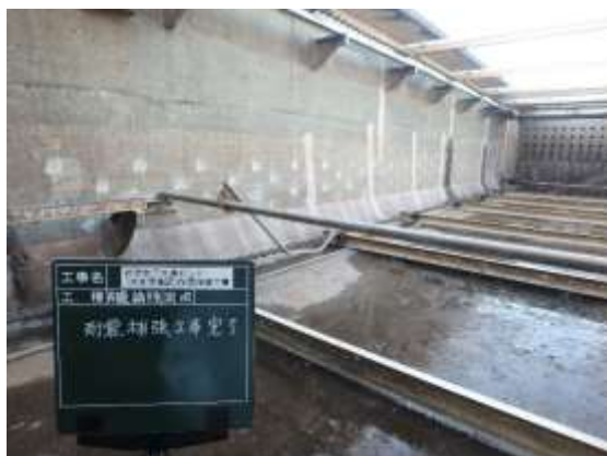
下水道施設耐震補強工事の様子
