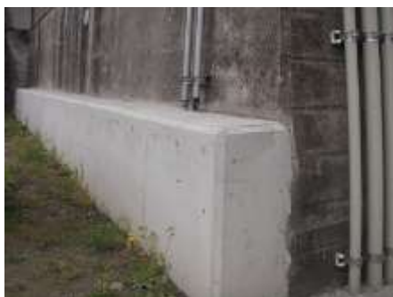
耐震補強（増し打ちコンクリート）
