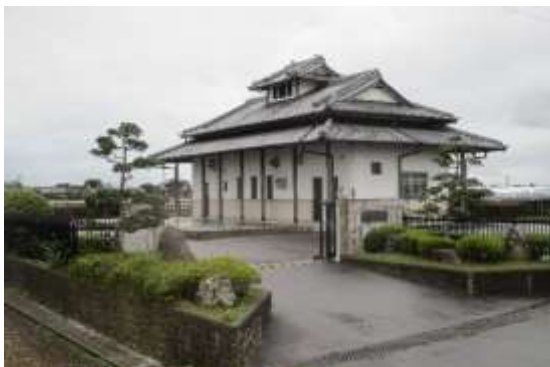
諸富北部地区農業集落排水施設
