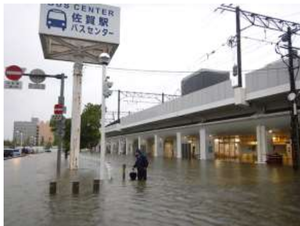
令和元年豪雨災害時の状況
