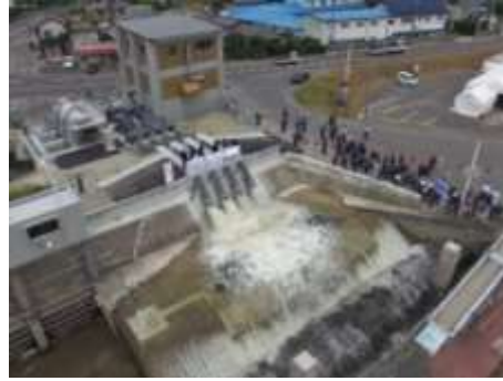
石塚雨水ポンプ場
