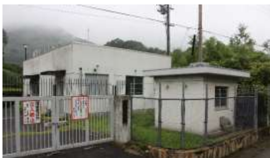
春日第2浄水場
