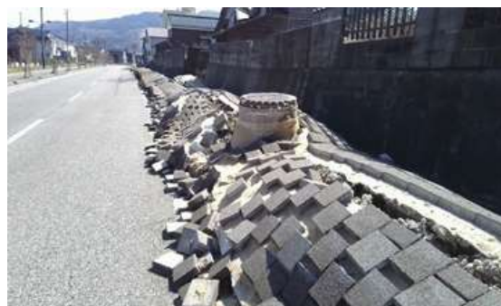
地震による被害の様子（石川県輪島市）
