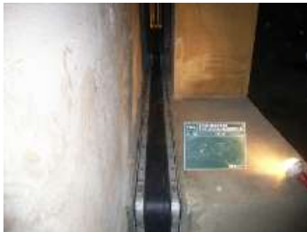
耐震補強（可とう継手）
