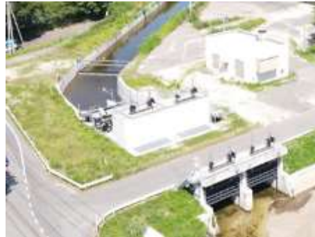
尼寺排水機場
