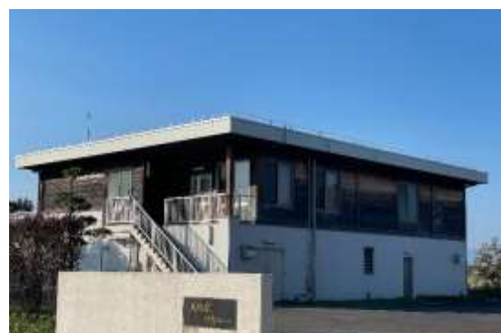
蓮池地区農業集落排水施設
