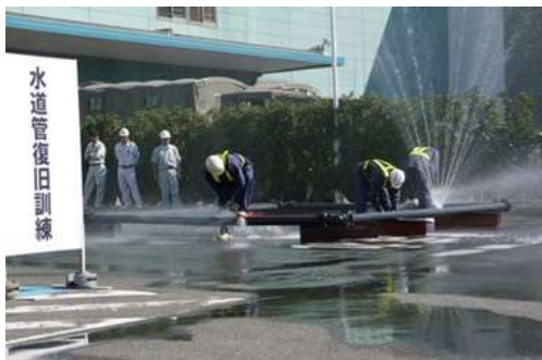
水道管復旧訓練の様子
