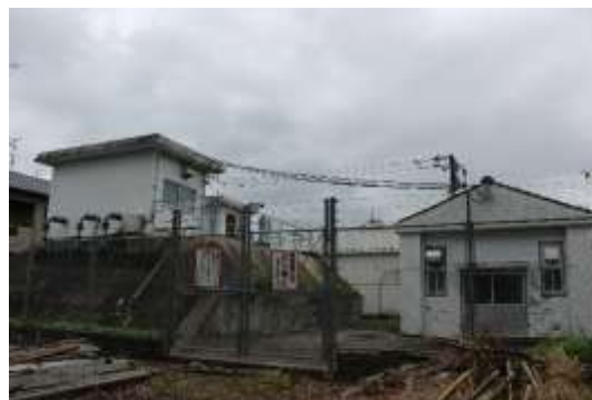
春日第1浄水場
