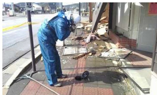
漏水調査の様子（石川県輪島市）
