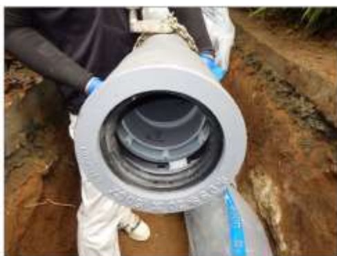
耐震管（GX形水道管）
