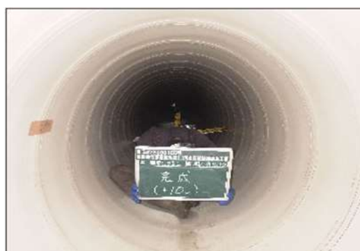
下水道管路の様子（更生後）
