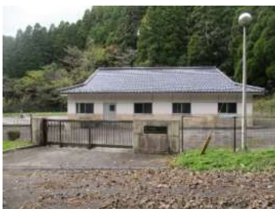
富士北部地区農業集落排水施設
