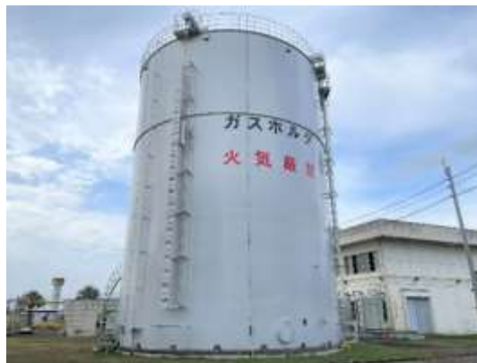
消化ガス（自家発電に利用）
