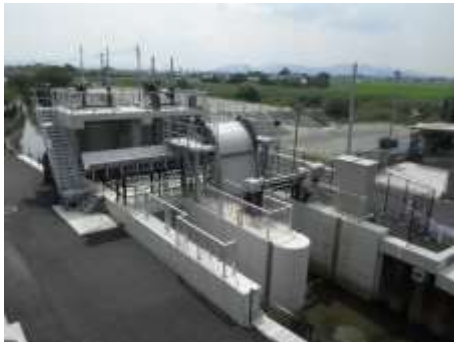
黒外雨水ポンプ場
