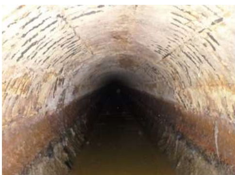
下水道管路の様子（更生前）
