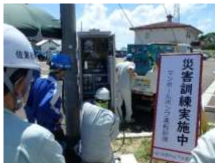
マンホールポンプ運転訓練の様子
