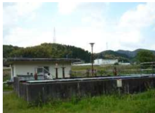
工業用水道浄水場
