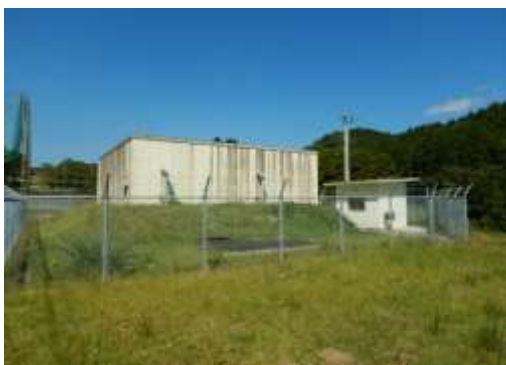
工業用水道配水池
