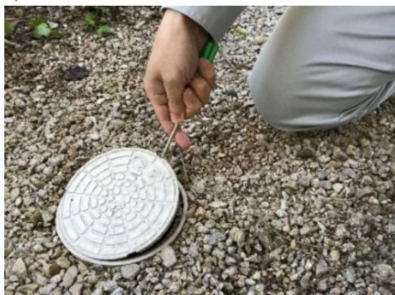
▲敷地内の排水設備に設置してある柵の蓋を開けて管内に詰まった空気を抜く。
