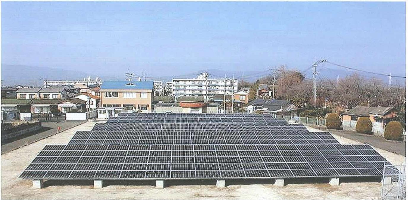
佐賀市上下水道局では、地球温暖化の原因となる二酸化炭素の発生を抑えるために、神野第2浄水場の配水池を活用して、太陽光発電システムを設置しました。
