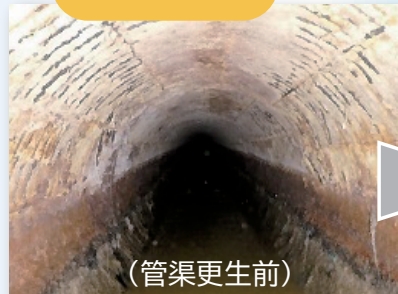
(腐食で鉄筋が見えている)
