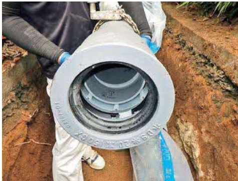
耐震管（GX形ダクタイル鋳鉄管）
