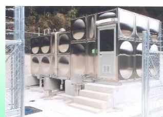
富士中央水道施設配水池(貝野地区)
