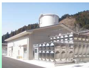
富士中央水道施設棟
