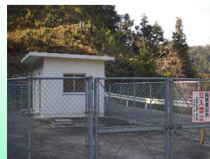
大和柚木水道施設
