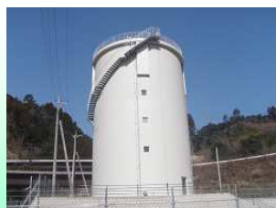
富士中央水道施設配水池
