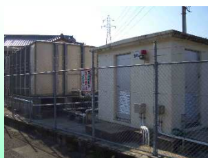
富士南部水道施設第一配水池
