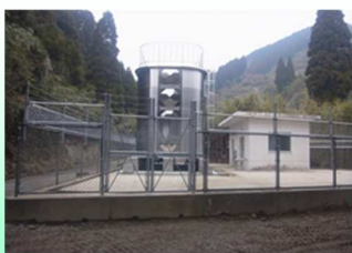
松梅北部浄水池
