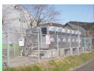
富士南部水道施設第二配水池
