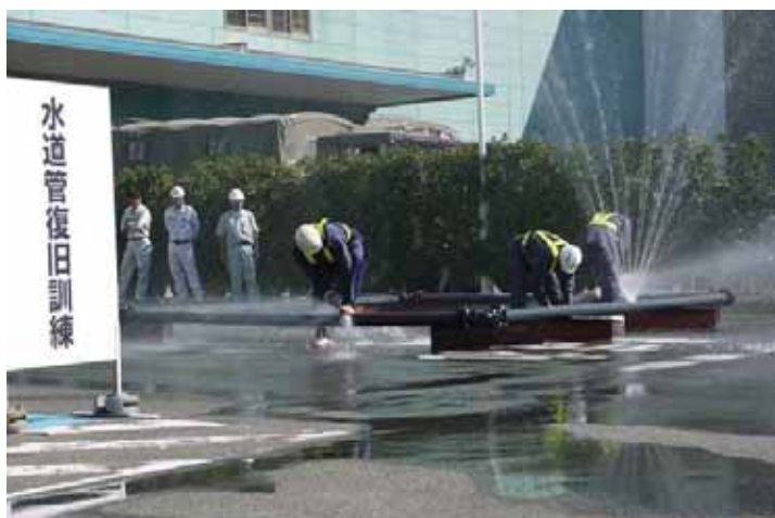
水道管復旧訓練の様子
