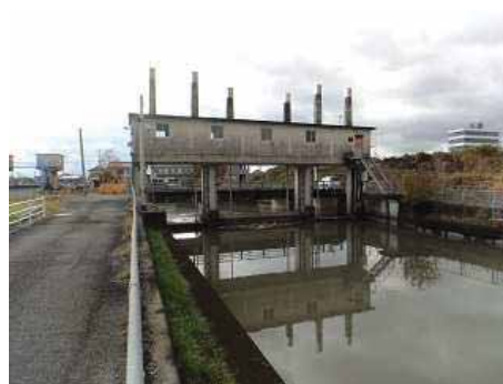
大溝川雨水幹線（大井手堰）
