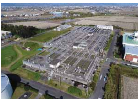
佐賀市下水浄化センター 水処理設備
