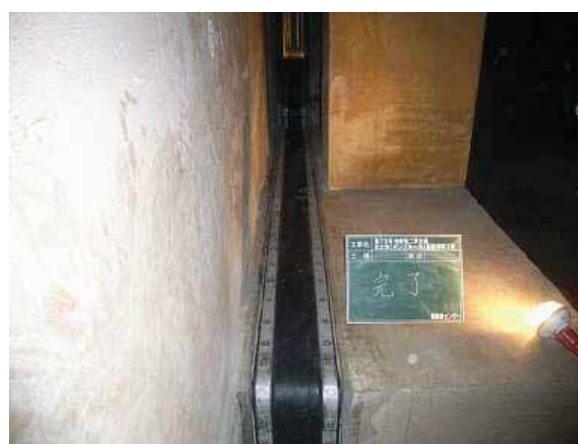
耐震補強② 可とう継手
