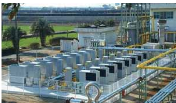
消化ガス発電施設
