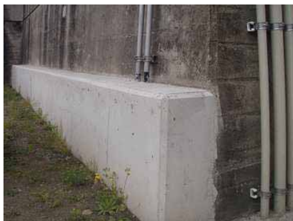
耐震補強① 増し打ちコンクリート
