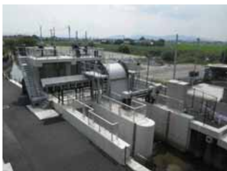
厘外雨水ポンプ場
