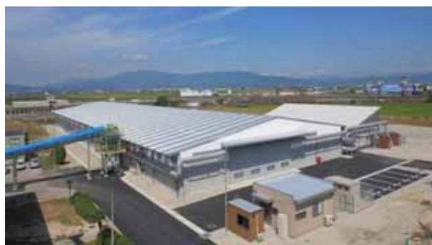
汚泥堆肥化施設
